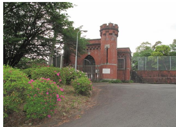
100年前の姿のまま現役で稼働する 第一高区配水池
