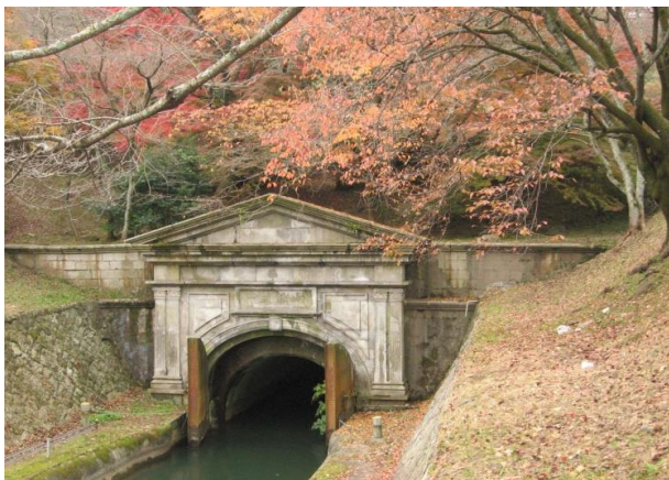
トンネル入口
