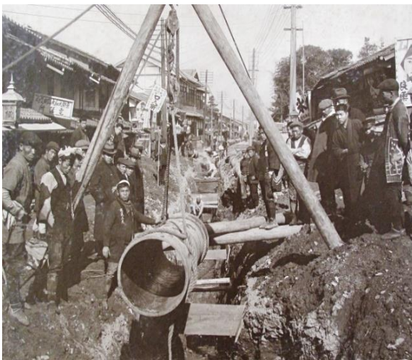
建仁寺前での水道管布設工事
